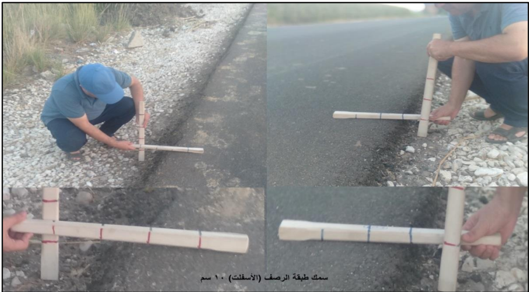
صورة (٦) صغر سمك طبقة الرصف على إحدى طرق المركز التي يعاد رصفها
