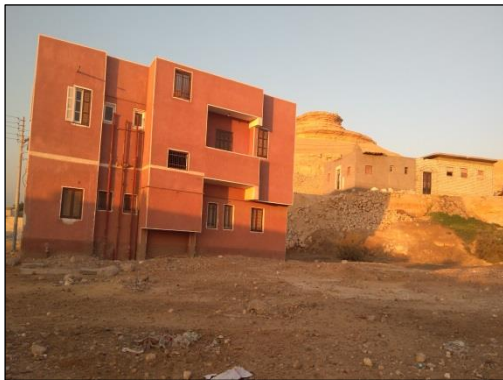
صورة (٢٦) مبني الوحدة الصحية وبعض المساكن بالقرب من تلال الحافة الجبلية بقرية بني عقبة
