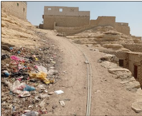
صورة (٢٢) الطريق إلي المساكن أعلي الحافة وظهور مواسير نقل المياه إلي أعلي مع انتشار القمامة
