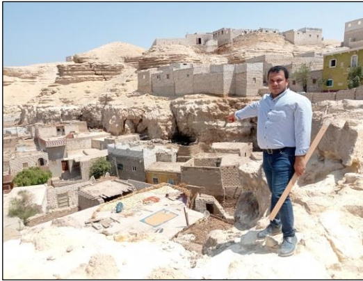
صورة (٢٠) بناء المنازل أسفل وأعلي منحدرات الحافة التي تكتنفها الفواصل والشقوق مما يهدد حياة السكان
