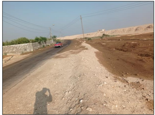
صورة (٣٦) نشع المياه الأرضية بمدخل قرية الحبيبة
