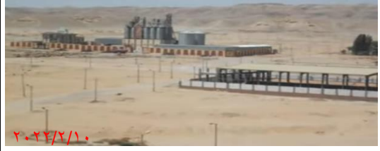
صورة (٩) عدم اكتمال رصف لطرق منطقة الدراسة
