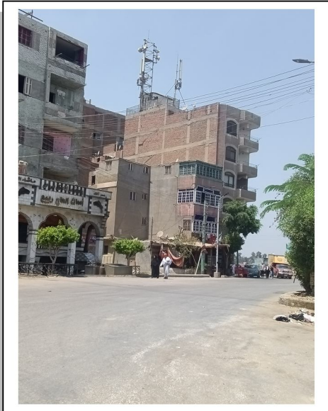
صورة (٨) محطة تقوية الهاتف المحمول أعلى عقار ستة طوابق (فودافون). (مدينة منشأة القناطر)
