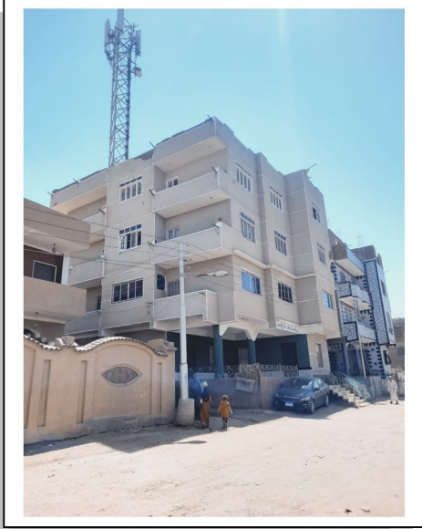
صورة (٦) محطة تقوية الهاتف المحمول أعلى عقار أربعة طوابق (أورنج). (قرية كفر حجازي)
