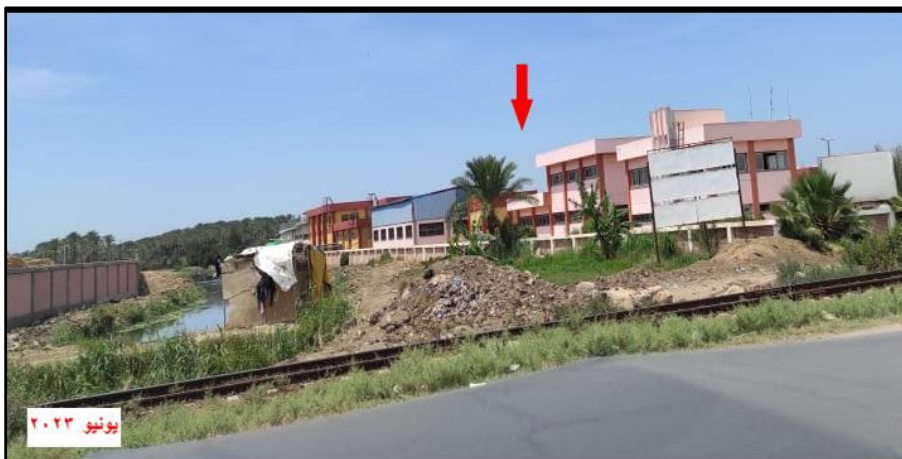
صورة (٣) محطة معالجة الصرف الصحي بجنوب مدينة إدكو عام ٢٠٢٣ م
