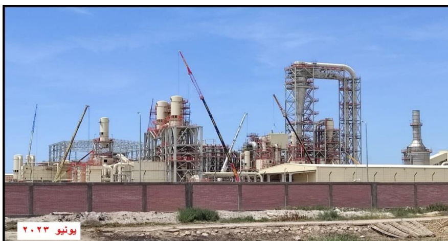
صورة (٤) مصنع إنتاج الألواح الخشبية بجنوبي شرقي الكتلة المبنية لمدينة إدكو عام ٢٠٢٣
