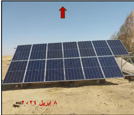
صورة (٤) نموذج للوحدات الكهروضوئية التي تقل قدرتها المركبة عن ١٠ ك.و بقرية المنيرة
