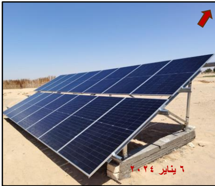
صورة (٢) نموذج للوحدات الكهروضوئية التي تتراوح قدرتها المركبة ما بين (١٠ - ٢٠) ك.و بالشركة ١٧
